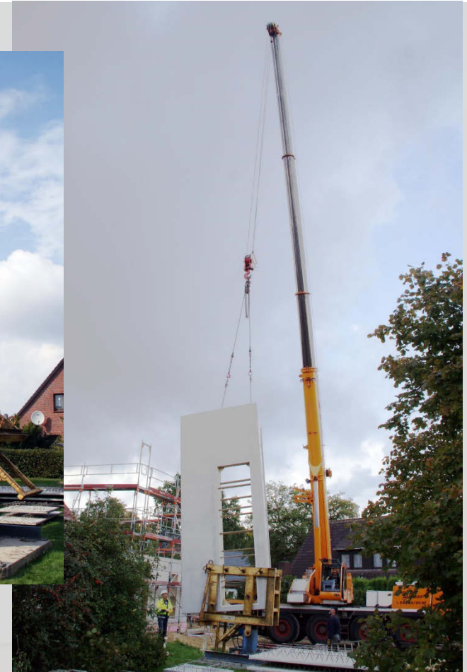
Thermowand in Einbaulage
