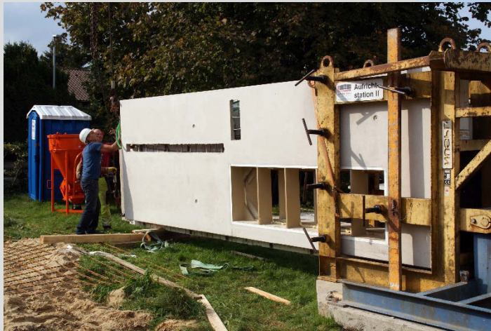
Thermowand in Aufrichtstation
