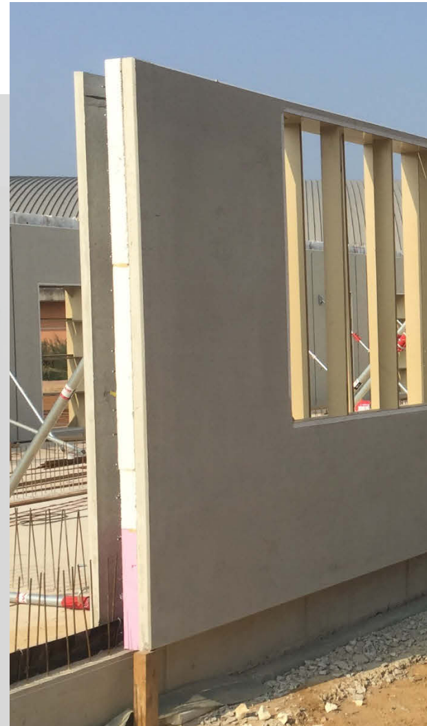
Thermowand mit EPS/XPS-Dämmung
