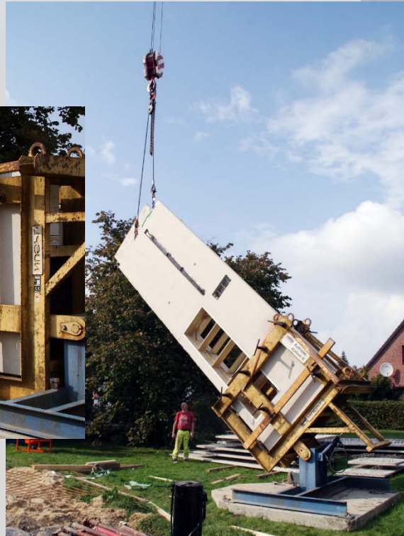
Aufrichten mittels Mobilkran
