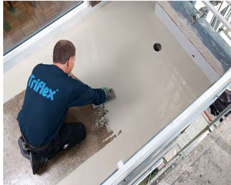
Aufbringen der vliesfreien Beschichtung
