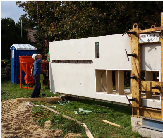
Thermowand in Aufrichtstation
