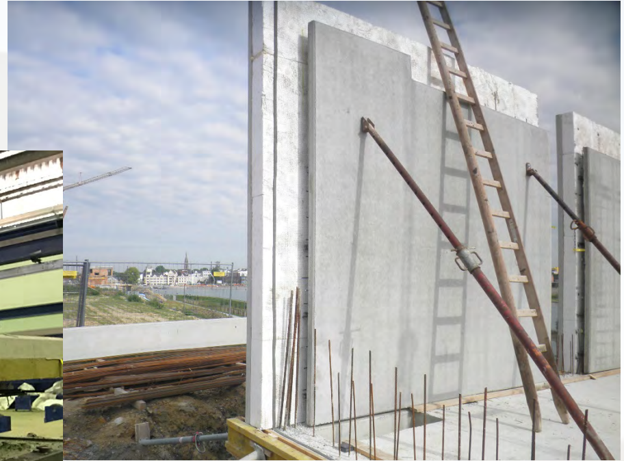
Thermowand mit EPS/XPS-Dämmung
