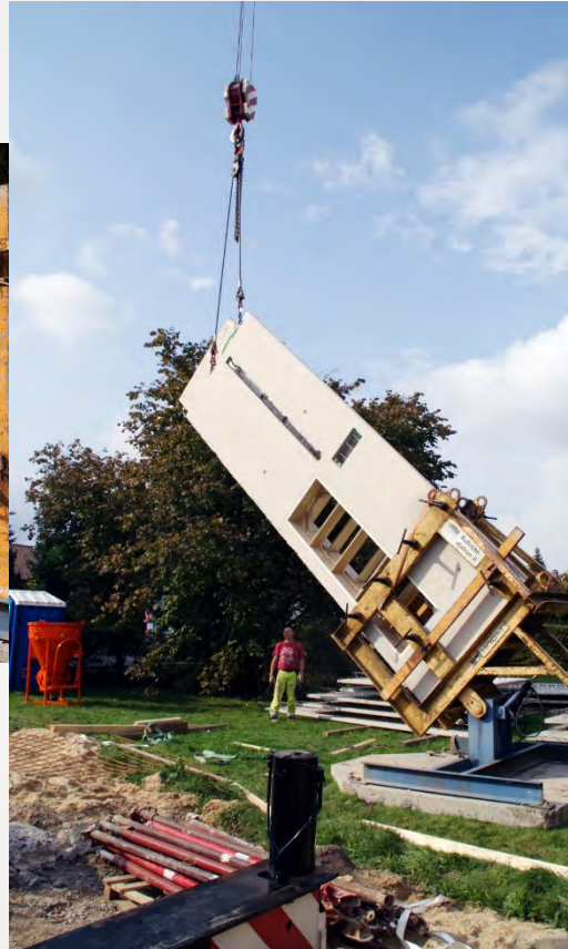
Aufrichten mittels Mobilkran
