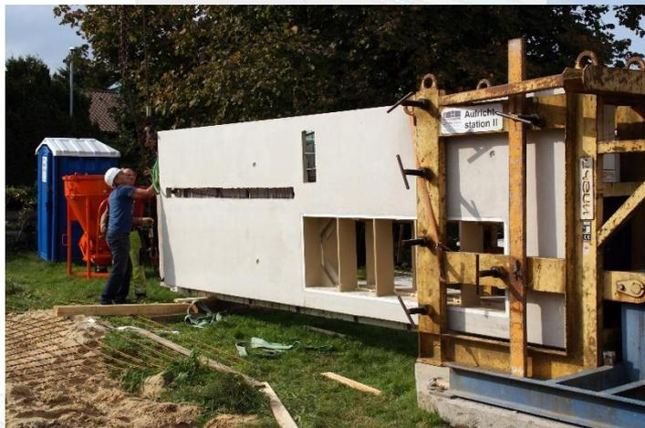
Thermowand in Aufrichtstation
