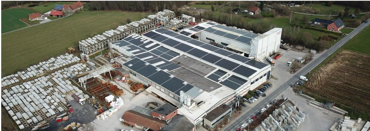
Ein erster Schritt hierfür ist unsere Ende 2022 montierte Photovoltaikanlage. Diese ist so ausgelegt, dass sie etwa 900.000 kWh Strom pro Jahr produziert, sodass wir ab 2023 mindestens 30 % unseres aktuell benötigten Stroms selbst produzieren können.
